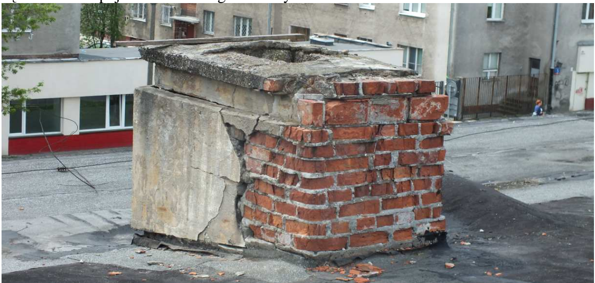
Fot.4.11 Widok komina z przewodem wentylacyjnym w poziomie stropodachu
