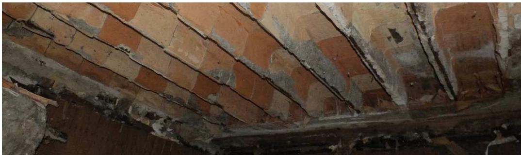
Fot.4.5 Widok stropu Ackermanna w poziomie piwnicy poza obrysem hali
