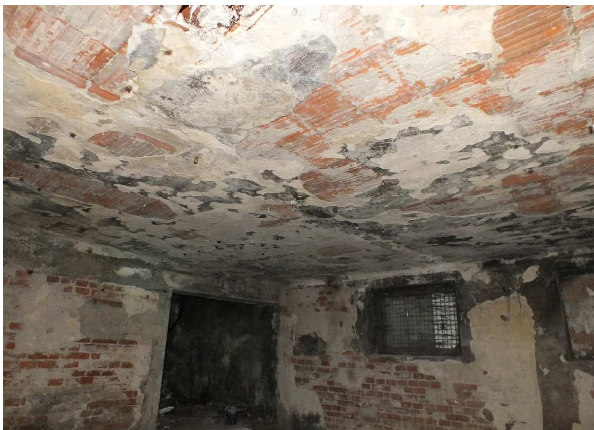
Fot. Z.23. Widok stropu typu Ackerman (strop pod wejściem do hali)
