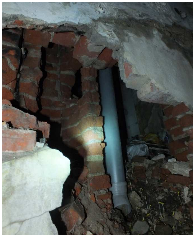
Fot. Z.18. Widok korozji w obrębie pionów rur spustowych
