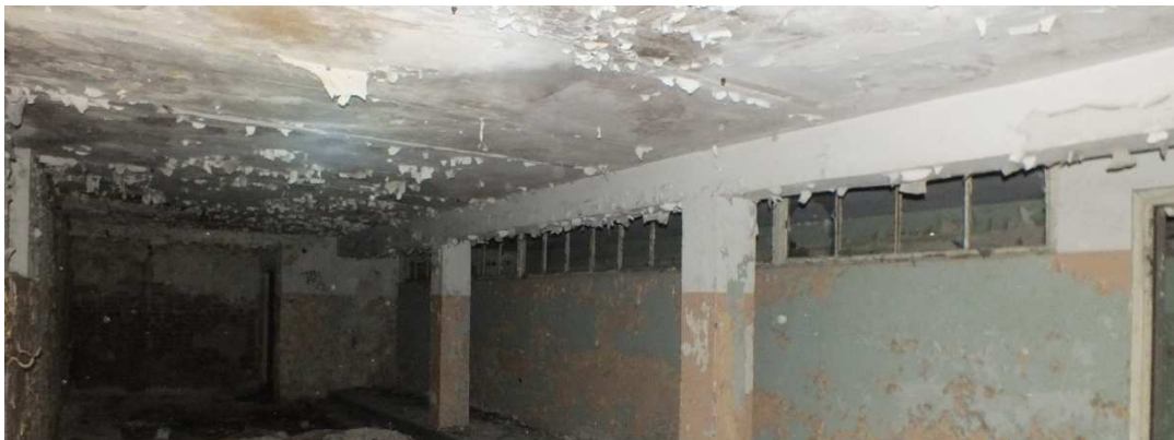
Fot.4.7 Widok płyty żelbetowej nad piwnicą w strefie ruchu
