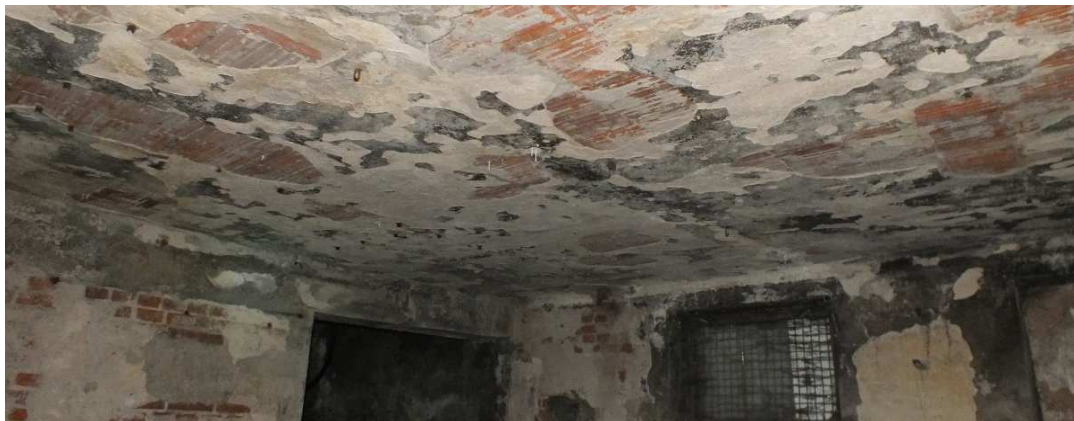
Fot.4.6 Widok stropu Ackermanna pod wejściem głównym do hali
